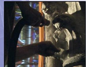
Les travaux minutieux du décapage, millimètre par millimètre, ont permis de retrouver des enduits colorés antiques. La redécouverte des enduits d'origine s'est effectuée par un « peeling » par latex qui aspire les couches de crasses et de salissures, laissant apparaître les traces des polychromies anciennes. Suivez les travaux sur le blog de Denis Metzzen, tailleur de pierre de l'entreprise Tollis :
